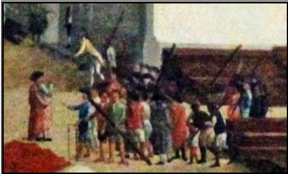
Figura 8 - Detalhe da tela Reedificação do Recolhimento de Nossa Senhora do Parto , de Muzzi, 1789
