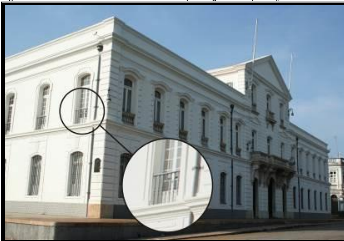
Figura 51 - Palácio dos Governadores – em destaque, os gradis nas portas-janela. Belém, Pará
