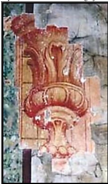
Figura 238 - Detalhe da prospecção cromática realizada na Igreja de São João Batista, Belém, Pará
