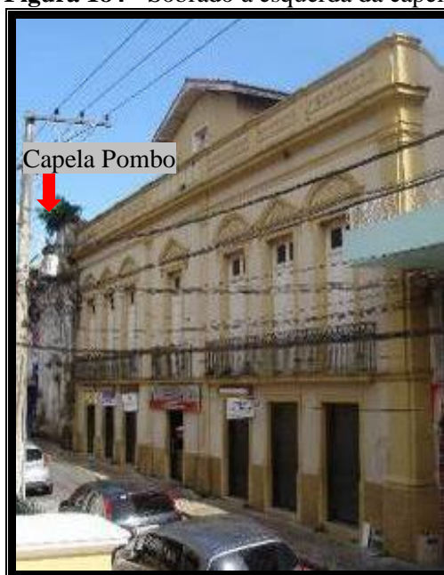
Figura 184 - Sobrado à esquerda da capela
