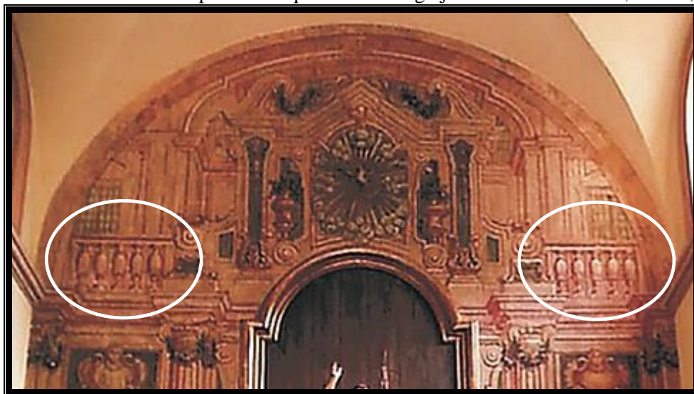
Figura 257 - Balaústres da pintura de quadratura da Igreja de São João Batista, Belém, Pará
