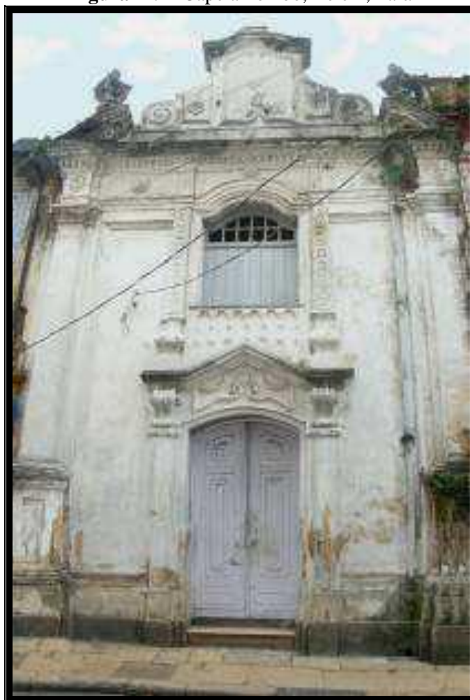
Figura 179 - Capela Pombo, Belém, Pará
