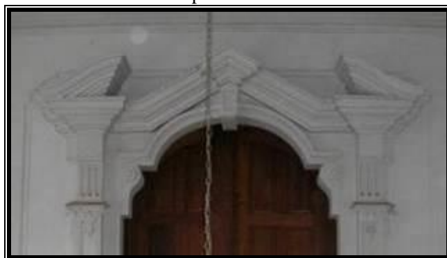
Figura 196 - Detalhe da tribuna da Capela do Palácio dos Governadores, Belém, Pará
