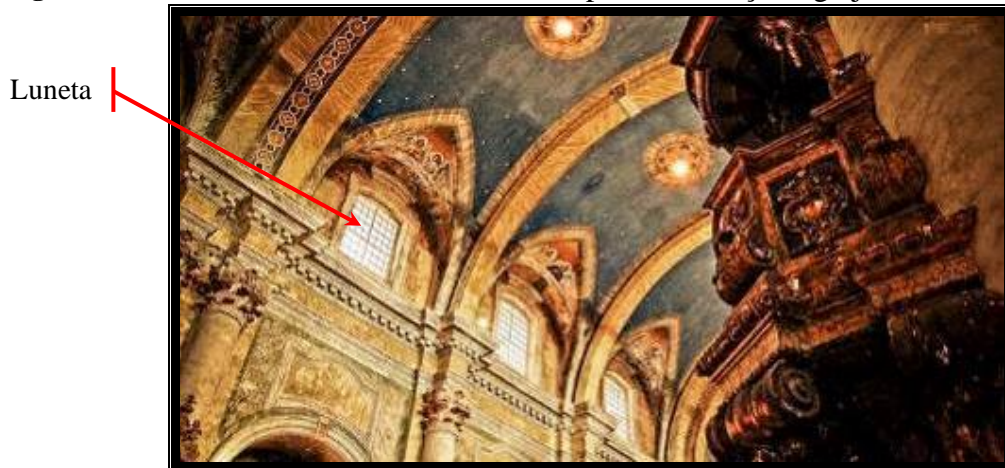
Figura 146 - Abóbada cilíndrica com entradas para iluminação, Igreja do Carmo, Belém, Pará
