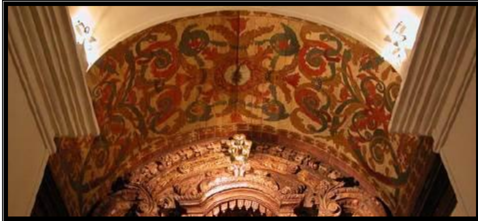
Figura 124 - Forro da 3ª capela do lado da Epístola, Igreja de Santo Alexandre, Belém, Pará
