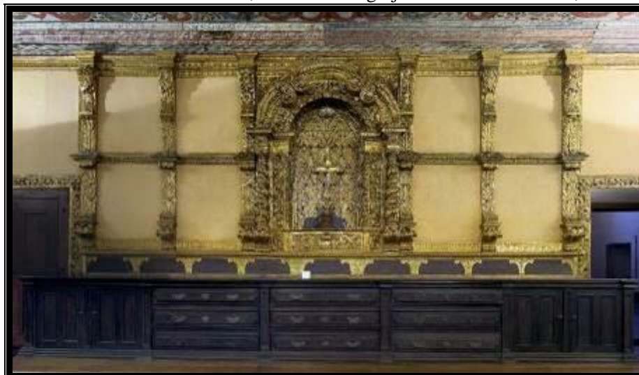
Figura 85 - Molduras sem as telas, Sacristia da Igreja de Santo Alexandre, Belém, Pará
