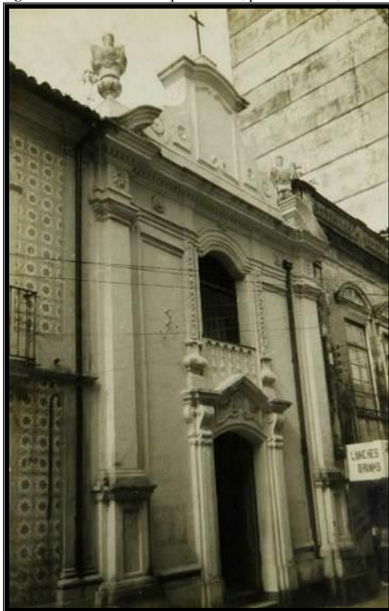
Figura 187 - Fachada da Capela Pombo, provavelmente, em 1981
