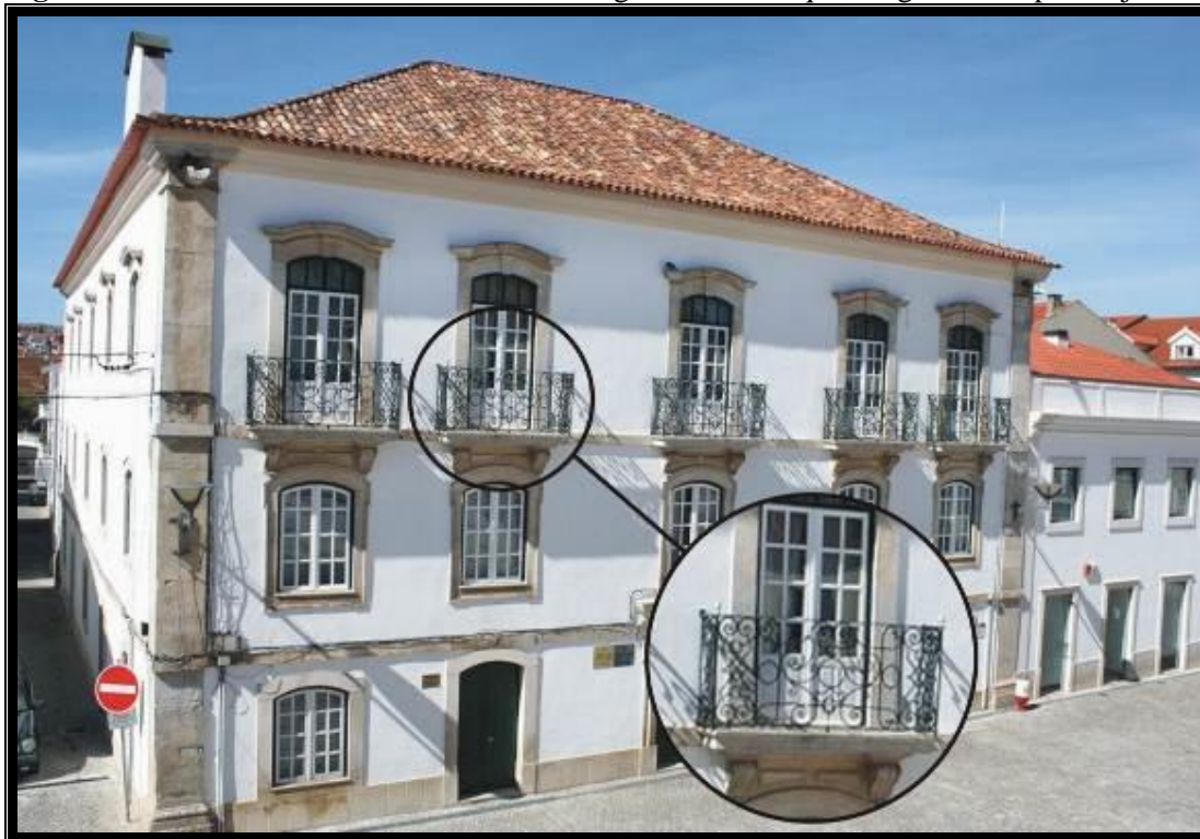
Figura 52 - Edifício Pombalino, Pombal, Portugal – em destaque, os gradis nas portas-janelas
