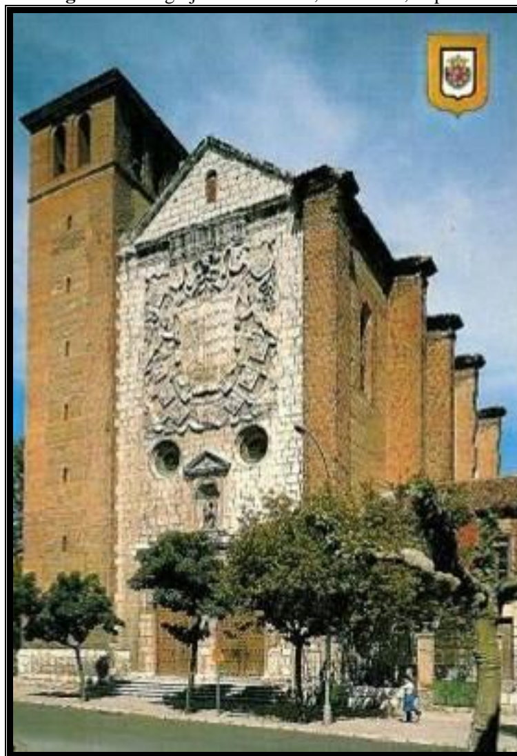
Figura 139 - Igreja de Madalena, Valladolid, Espanha
