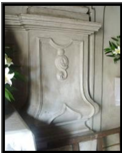
Figura 208 - Base de pilar em forma de bulbo no interior da Capela Pombo, Belém, Pará
