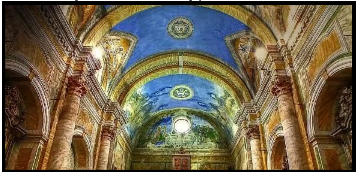
Figura 157 - Abóbada cilíndrica, Igreja do Carmo, Belém, Pará
