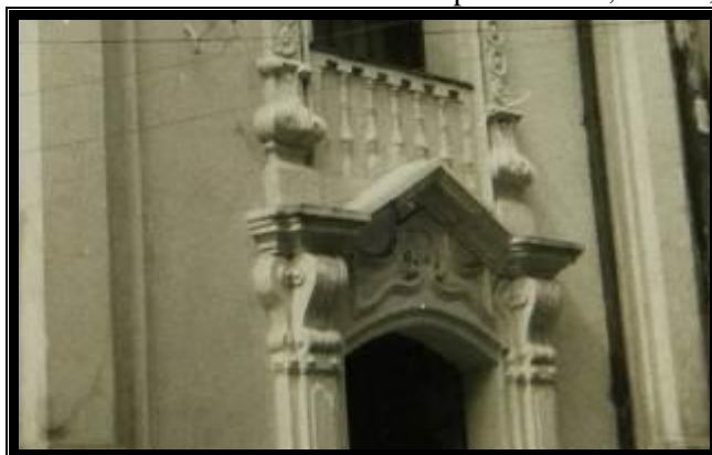
Figura 195 - Detalhe da fachada da Capela Pombo, Belém, Pará
