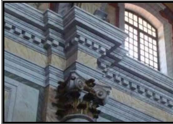
Figura 173 - Detalhe do entablamento da nave da Igreja do Carmo, Belém, Pará
