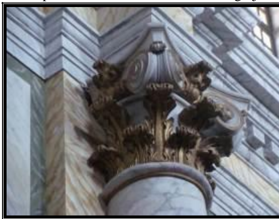
Figura 175 - Detalhe do capitel de uma coluna da nave da Igreja do Carmo, Belém, Pará
