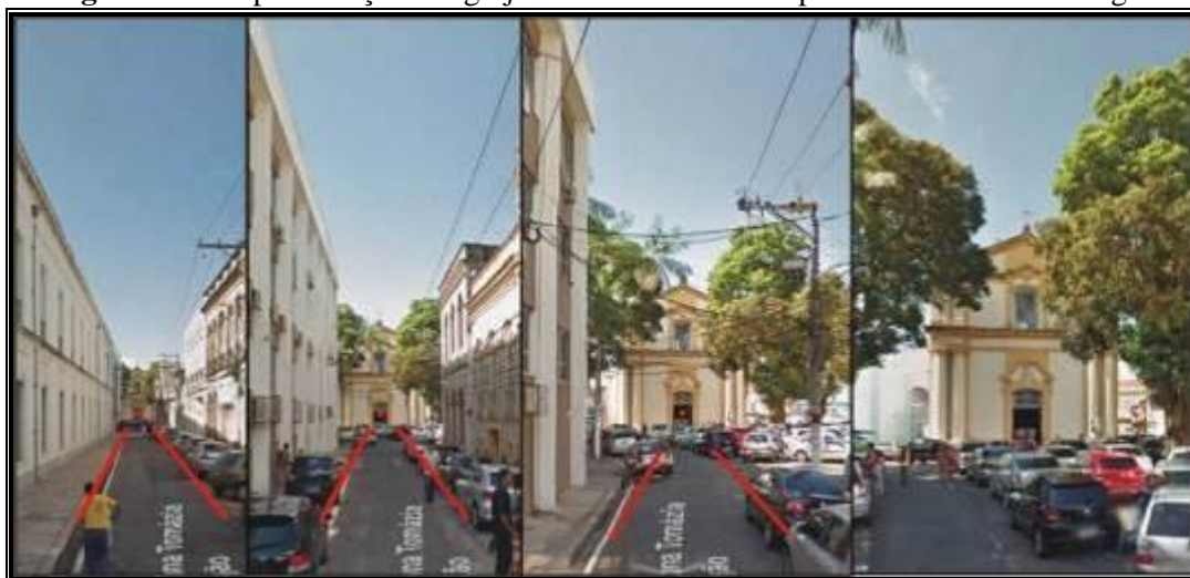
Figura 215 - Aproximação da Igreja de São João Batista pela Rua Tomázia Perdigão
