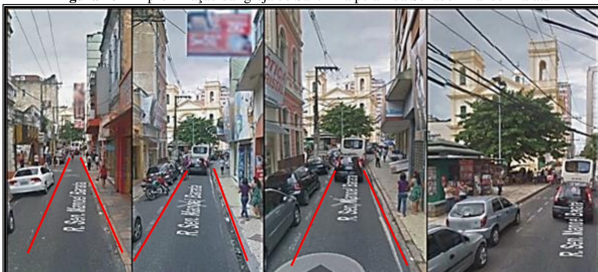
Figura 264 - Aproximação da Igreja de Sant'Ana pela Rua Senador Manoel Barata
