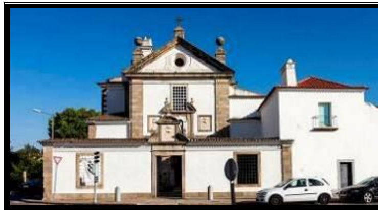
Figura 135 - Convento de Nossa Senhora dos Remédios, Évora, Portugal
