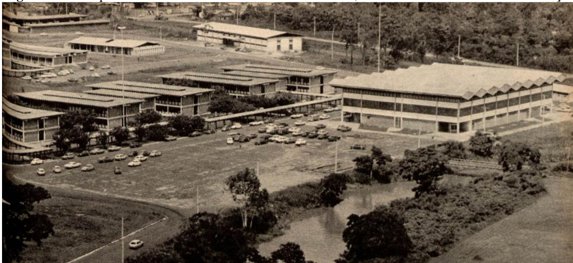
Figura 8 – Vista parcial do Núcleo Pioneiro do Guamá em 1978, vendo-se os edifícios da Administração
