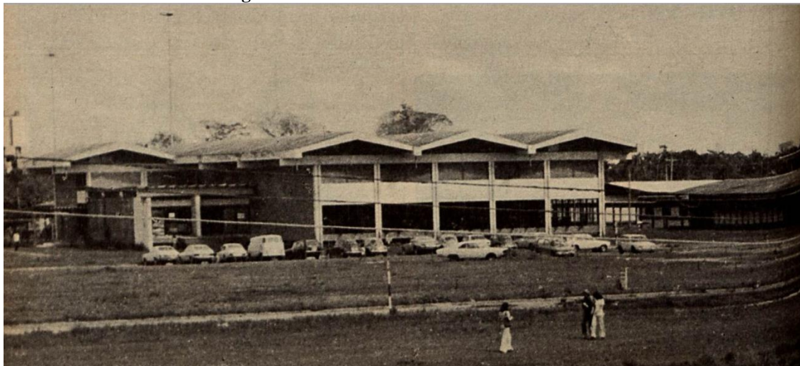
Figura 15 – Vista externa da Biblioteca Central
