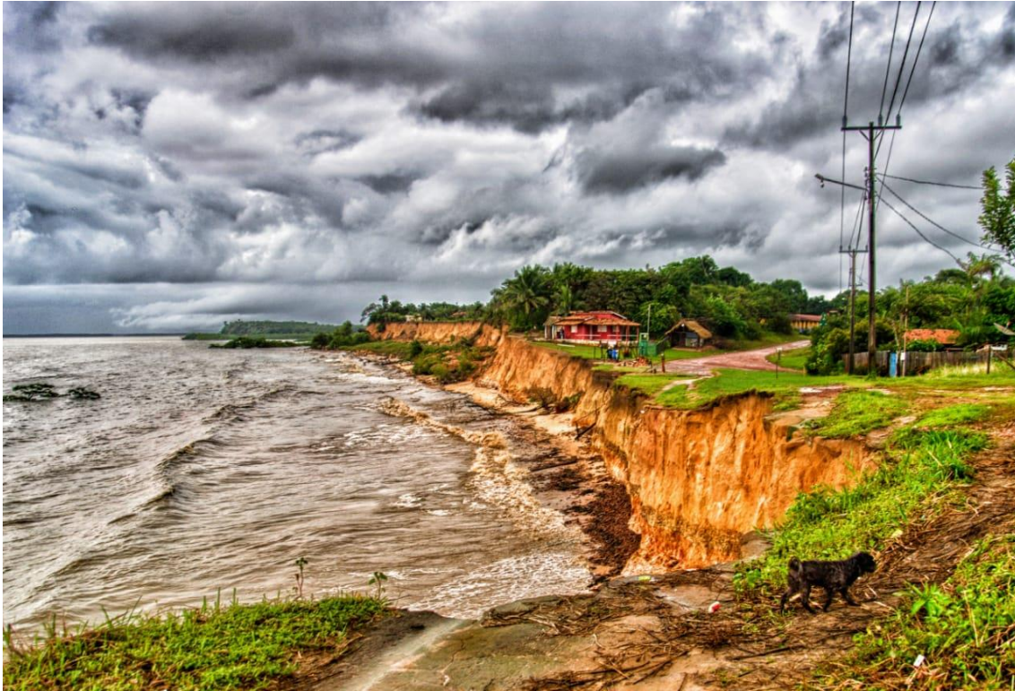
Figura 1 – Fim da PA-430 e início da rua Beira Mar, no vilarejo do 40 do Mocooca, num dia de marés altas e já bastante impactada pelas forças das águas marinhas (março de 2019)
