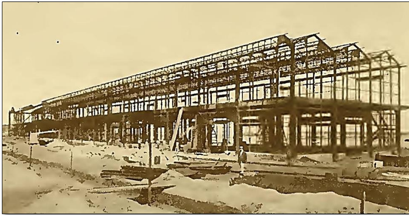
Figura 35: Estrutura de ferro de armazém. Fotografia. Os armazéns de dois pavimentos possuíam elevadores elétricos, piso de concreto reforçado e foram especialmente projetados para o armazenamento da borracha.
