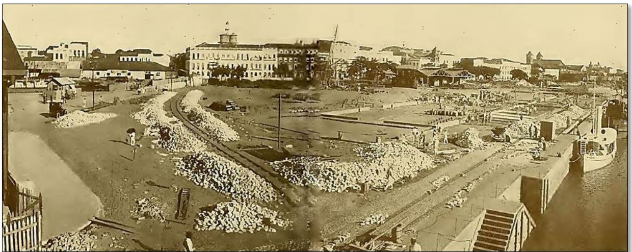
Figura 32: Construção do cais de cantaria na primeira seção. Fotografia. Observa-se, à direita, em primeiro plano, a escadinha do cais do porto e ao fundo as torres da Igreja das Mercês. No centro vemos o casario azulejado do Boulevard da República e o reservatório Paes de Carvalho ao fundo.
