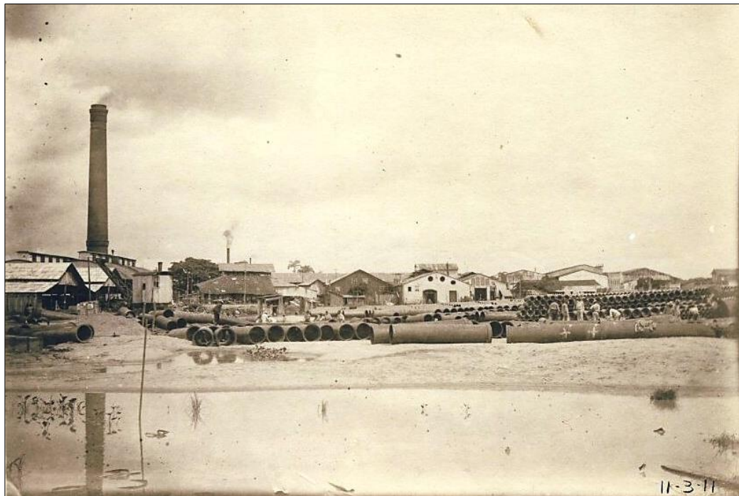
Figura 37: Obra do cais em frente às oficinas da Pará Electric Railways and Lighting Co. Ltd., na rua da Municipalidade, em 1911.
