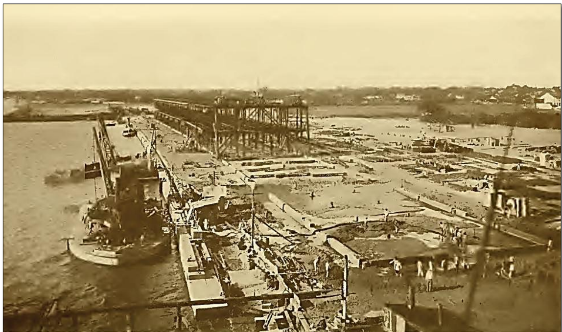
Figura 34: Construção de um dos armazéns de ferro de dois pavimentos junto ao cais. Fotografia. Fonte: HALE, op.cit. , p.690.
