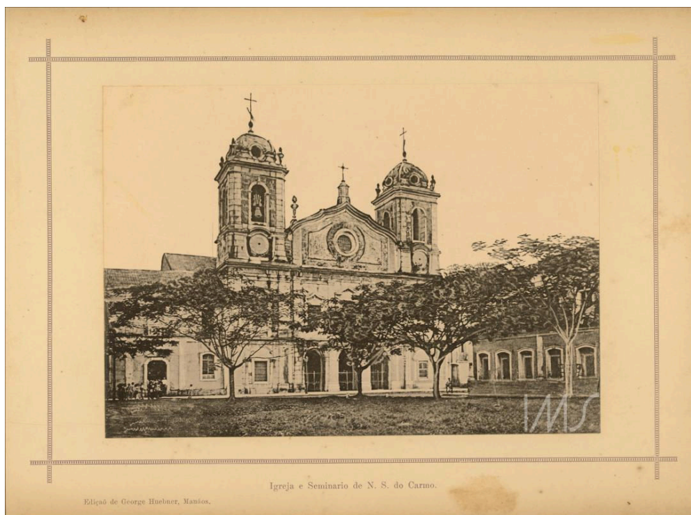
Figura 05- Igreja e Seminário Menor de Nossa Senhora do Carmo por volta de 1875.
