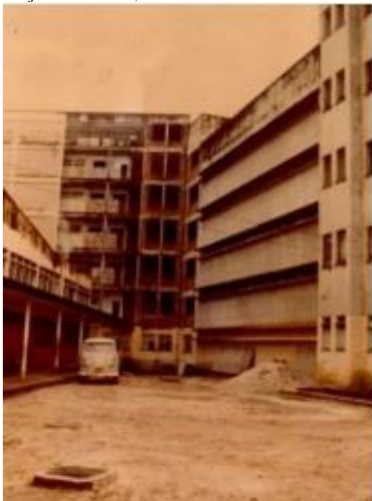
Figura 16 – Parte correspondente à área leste-sul em junho de 1973, com as obras não finalizadas
