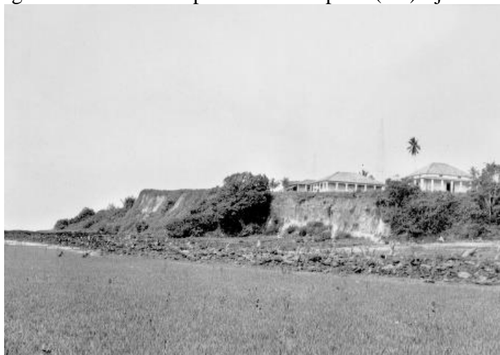
Figura 17: Paredão da praia de Salinópolis (PA) - jun. 1953
