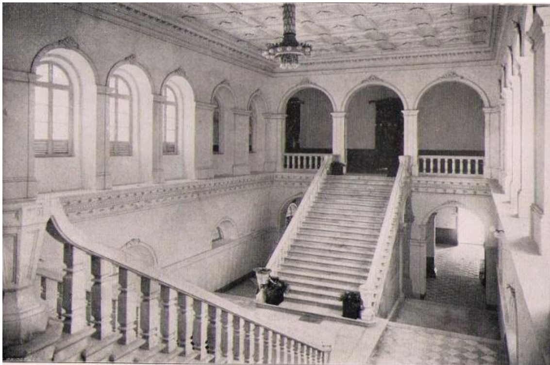
Figura 17 – Escadaria central e entrada do gabinete do intendente
