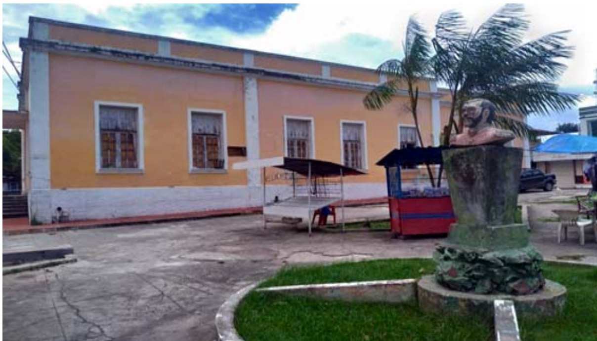
Figura 23: Antigo prédio da Prefeitura Municipal de Parintins. Localizado na Praça Eduardo Ribeiro. 622
