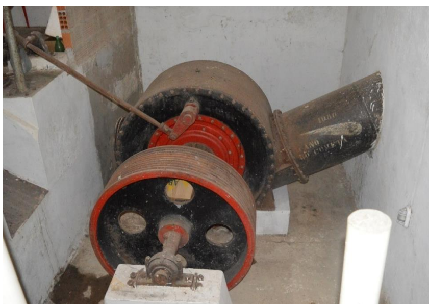
Figura 10: Turbina Francis de 110 Kw da usina de Itapecuruzinho.
