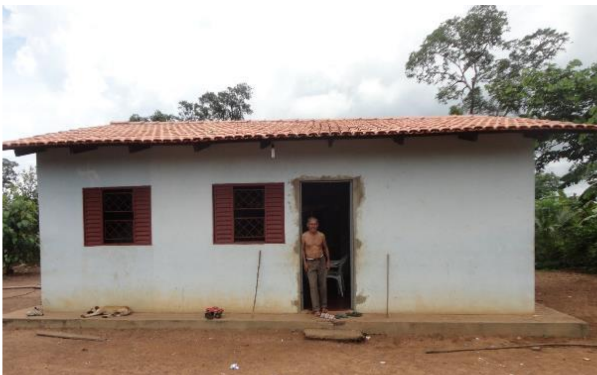
Figura 46: Casa no reassentamento Mirindiba com estrutura original.
