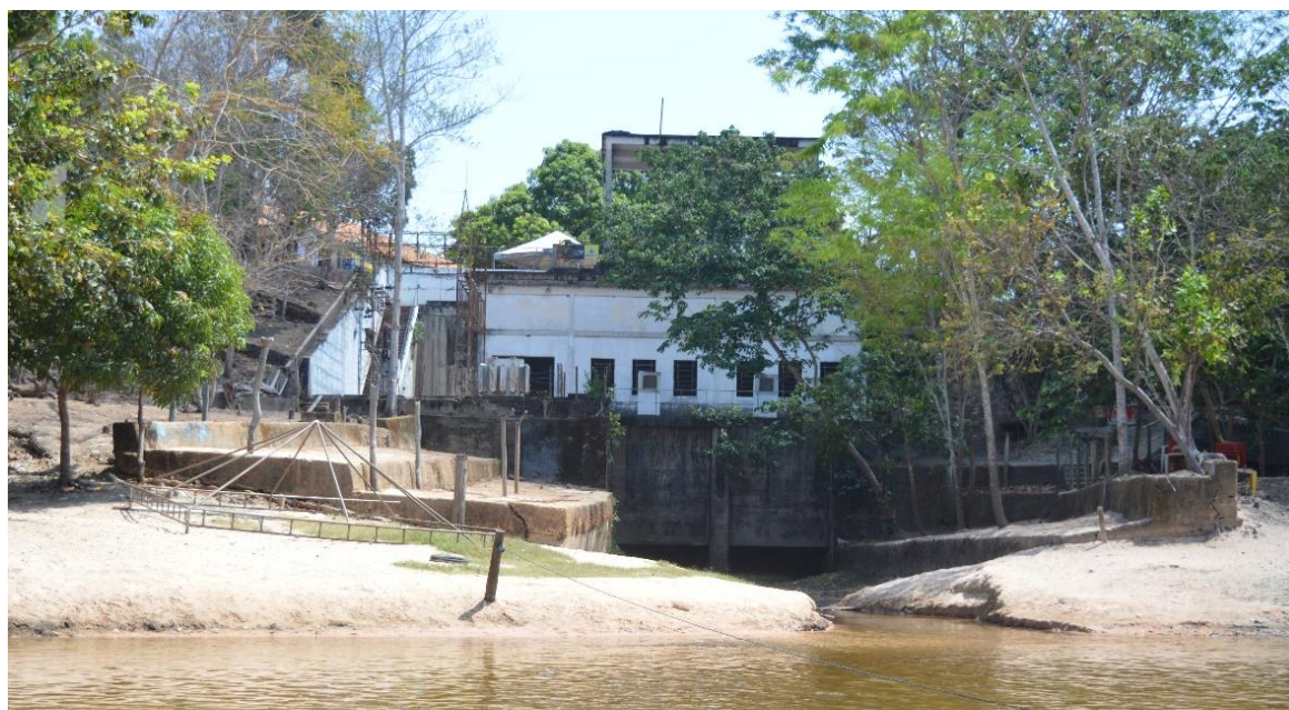
Figura 11: usina construída ao lado da hidrelétrica de Itapecuruzinho.
