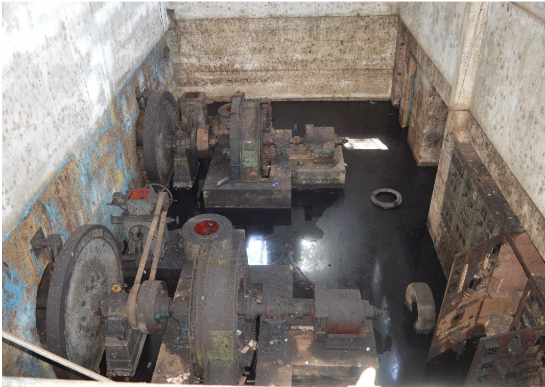
Figura 12: interior da ampliação da hidrelétrica de Itapecuruzinho.
