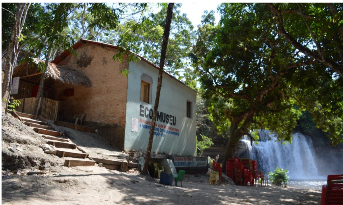
Figura 7: Casa de Força da hidrelétrica de Itapecuruzinho – Carolina/MA
