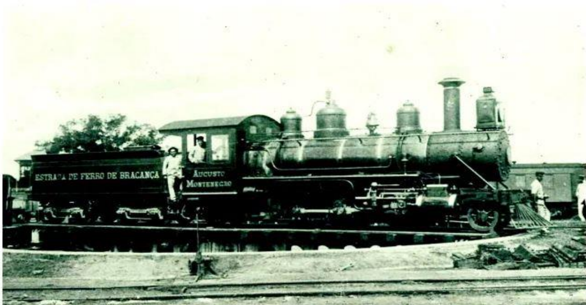
Figura 7 - Locomotiva Augusto Montenegro, pertencente a Estrada de Ferro de Bragança
