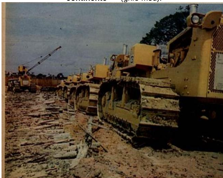
Figura 18 – “Tratores, guindastes, Caterpillar 977, motoniveladores, scrapers e equipamentos menores operam em Jarilândia e Monte Dourado. A maior frota de desmatamento do continente ” 685 (grifo meu).
