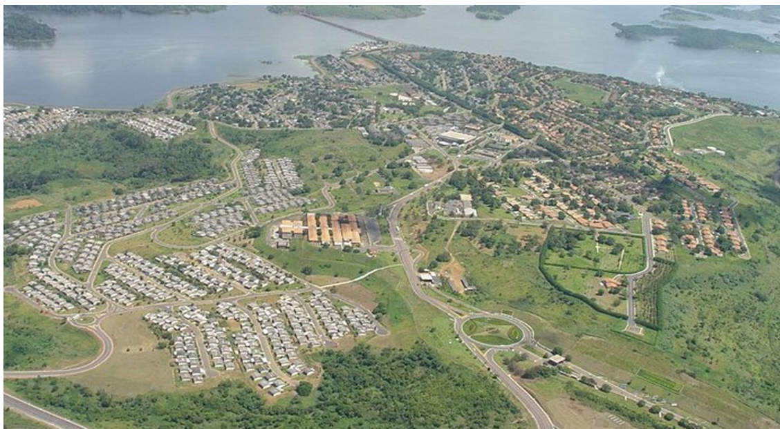
Fotografia 2- Cidade de Tucuruí vista aérea
