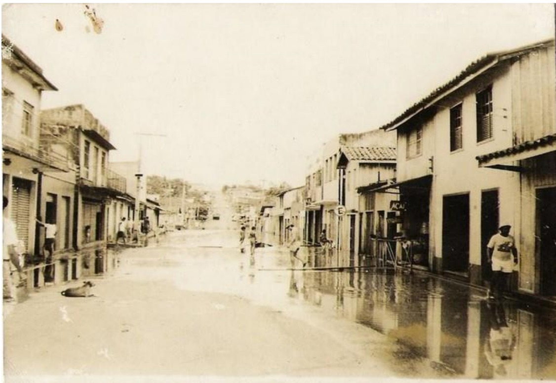
Fotografia 4 - Rua Assis de Vasconcelos - “Escorre Água”
