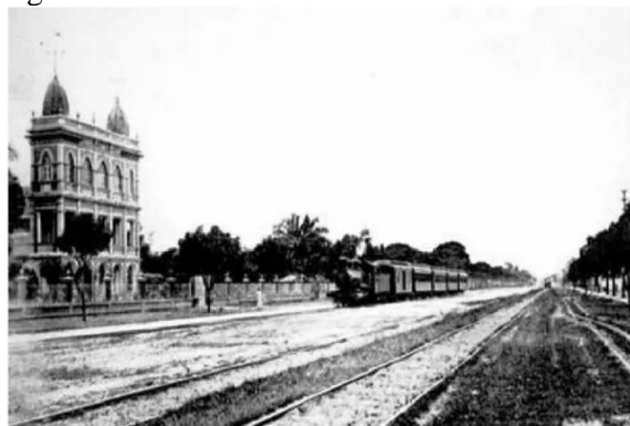
Foto 155 – Antigo prédio da Sociedade Civil de Agronomia e Veterinária do Pará
