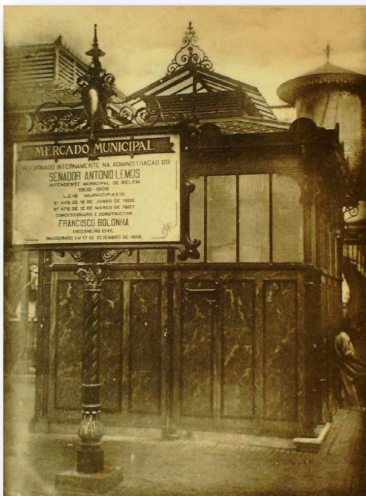
Figura 122 -Instalação Sanitária do Mercado da Carne
