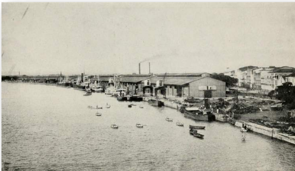
Figura 158 - Área devoluta ao lado dos armazéns construídos ainda servindo de depósitos
