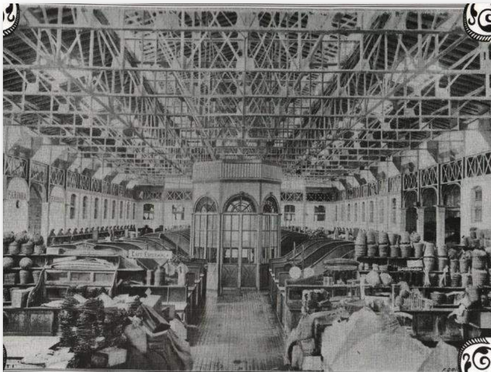
Figura 117 - Vista Interna do Mercado de Peixe, construído por Raimundo Vianna e Bento de Miranda.
