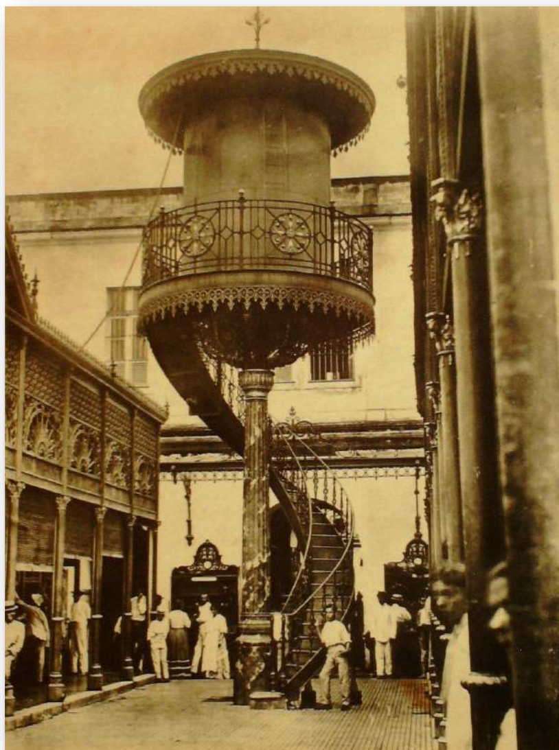
Figura 121 - Reservatório de Água do Mercado da Carne
