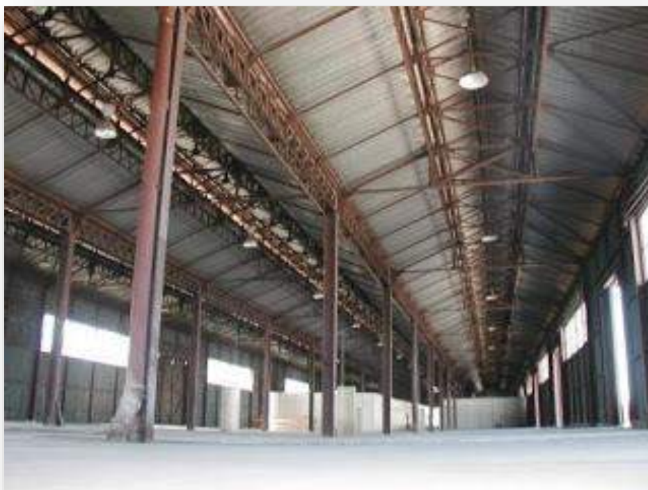
Figura 124 - Vista interna da cobertura do Armazém
