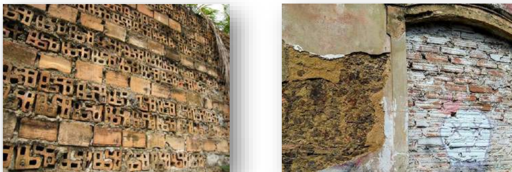
Figura 111 - Paredes de alvenaria de pedra e alvenaria de tijolos em “L”
