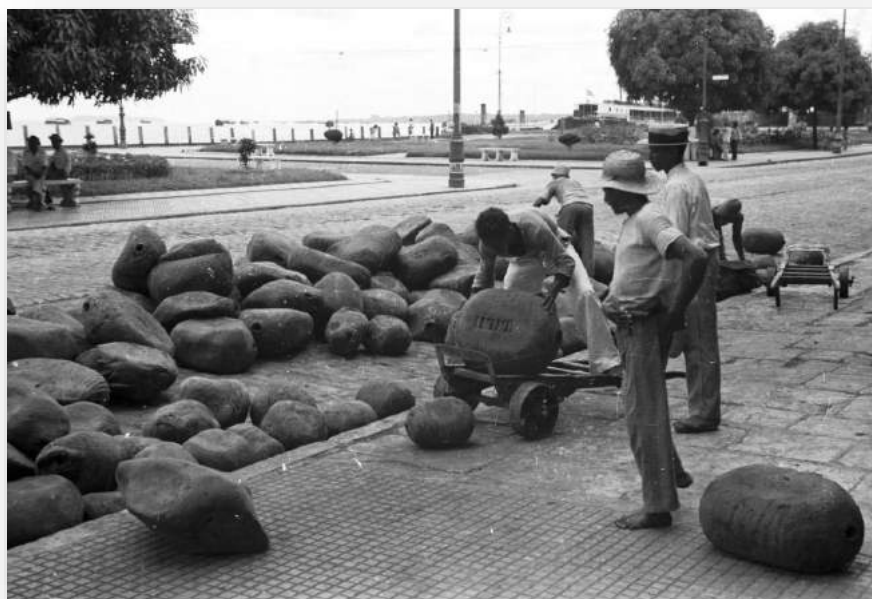
Figura 176 - Carregamento de pélas de borracha defronte à Praça do Pescador
