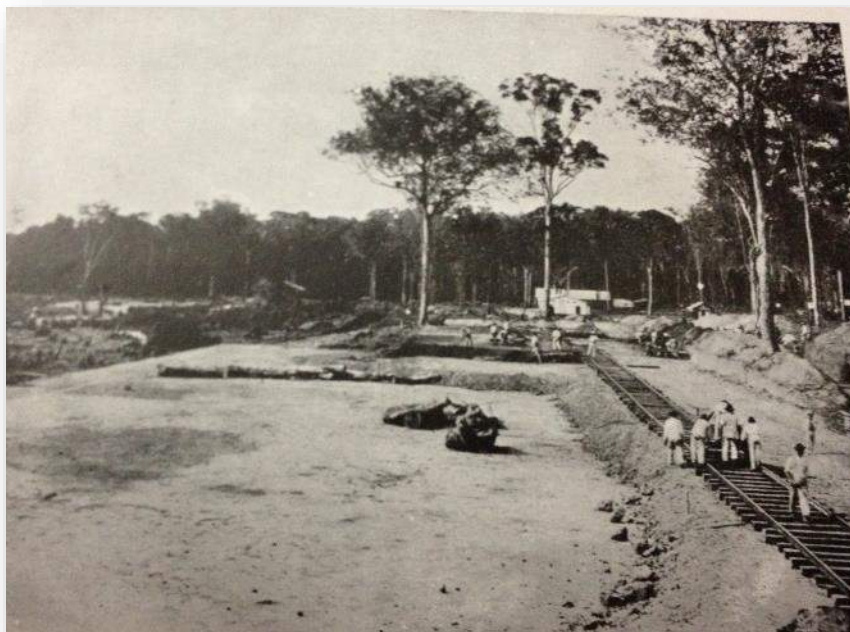
Figura 86 - Serviço de nivelamento do solo em Val de Cans nas oficinas construtoras do Porto
