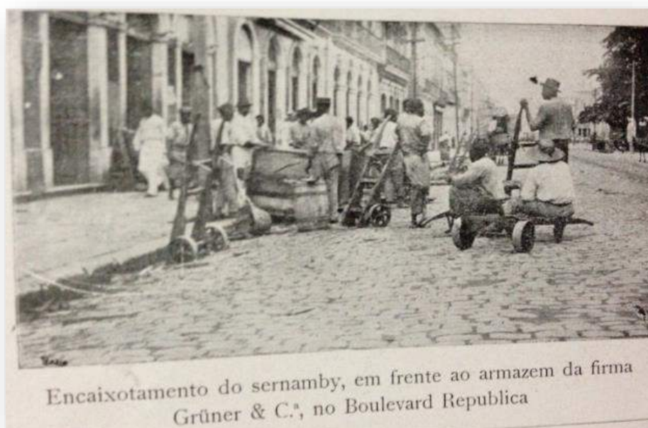
Figura 179: Encaixotamento em frente ao armazém da firma Gruner & Co.
