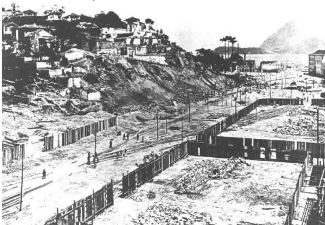
Figura 63 - Obras de abertura da avenida Central
