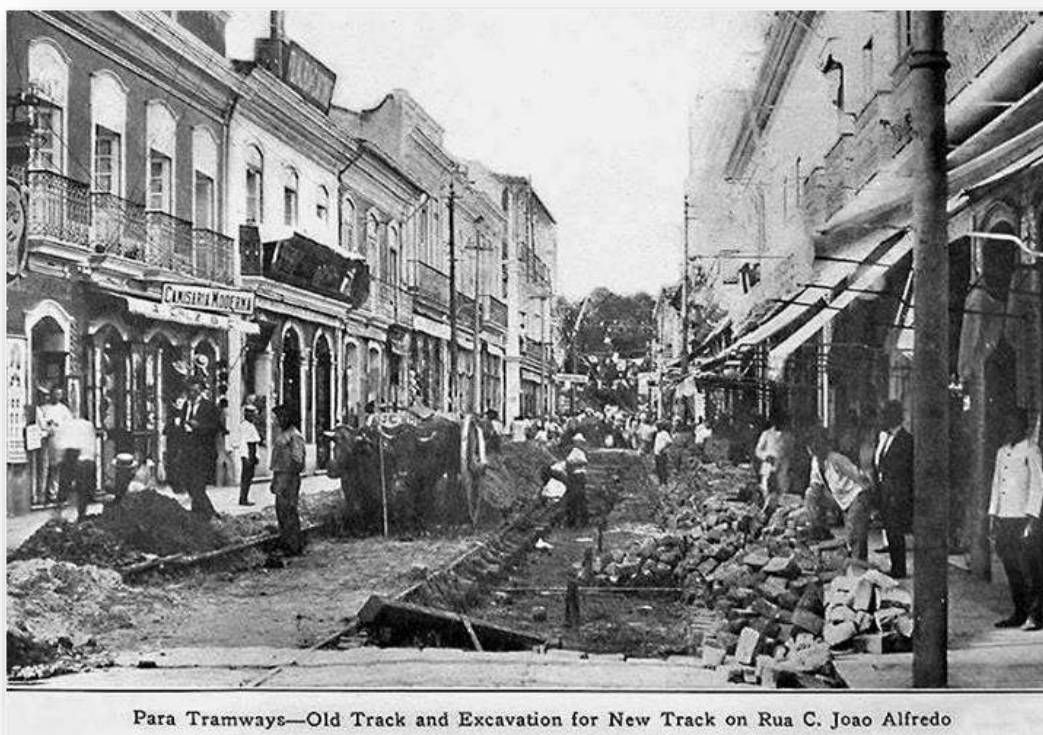
Figura 105 - Construção dos novos trilhos na Rua João Alfredo
