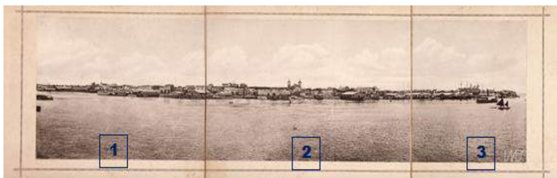
Figura 43 - Vista Geral do Porto de Belém
