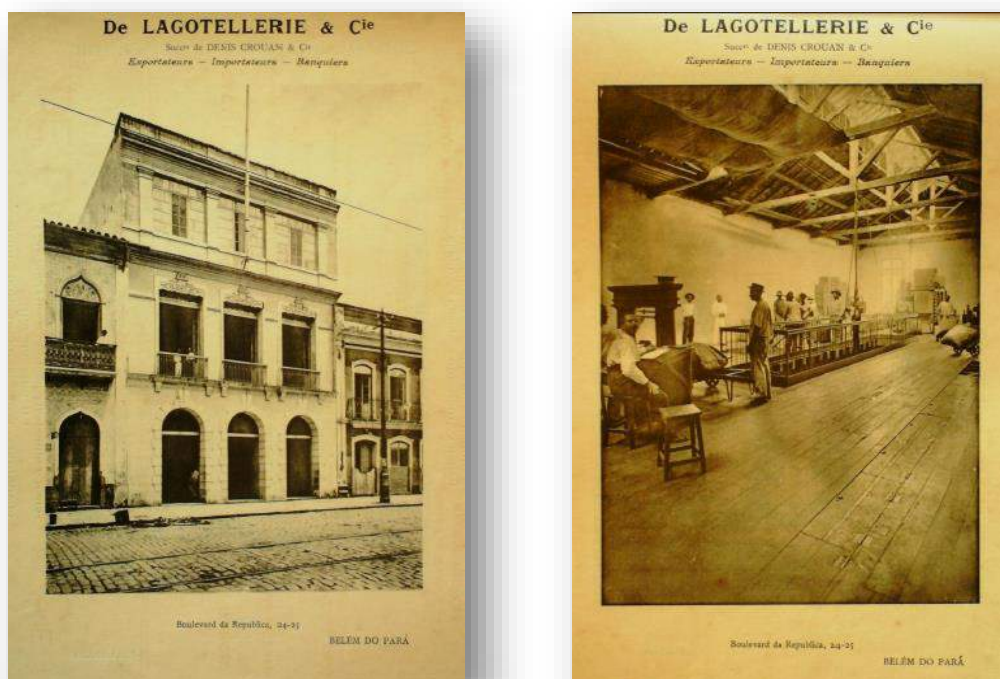
Figura 137 - Fachada do sobrado de De Lagotellerie & Cie e interior
