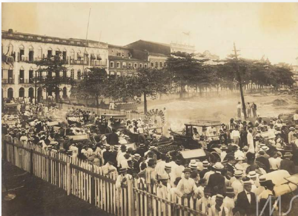
Figura 99 - Praça em construção do Boulevard da Republica com Tv. 15 de Agosto
